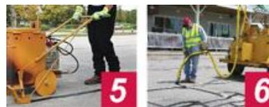
Las grietas deberán ser rellenadas con selladores para grietas Estimación del Material Requerido: Utilice el siguiente cuadro como una guía para estimar los requerimientos de material (basados sobre kilogramos de material necesario para 30.48 metros de grietas):
