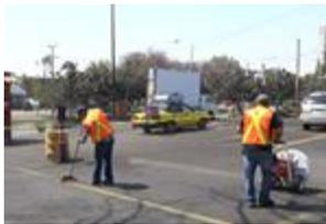
Permita que el sellador para pavimento de recién aplicación cure por lo menos 24 horas antes de aplicar la pintura para tráfico.
