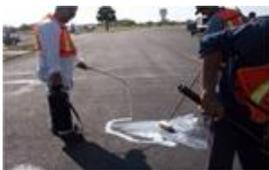
Las grietas deberán ser rellenadas con selladores para grietas SealMaster® con aplicación en caliente (CrackMaster™) o en frío (FlexMaster™). **Deje secar de 15 a 20 minutos antes de aplicar el sellador de superficies Neutral Concentrate.**
