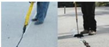
Los baches y oquedades de la superficie del pavimento se deben rellenar con una mezcla asfáltica apropiada aplicada en frío (Easy Patch™) o en caliente. **Deje secar de 30 a 40 minutos antes de aplicar el sellador de superficies Neutral Concentrate.**
